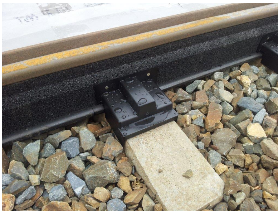
Obr.: Ukázka kolejových absorbérů
